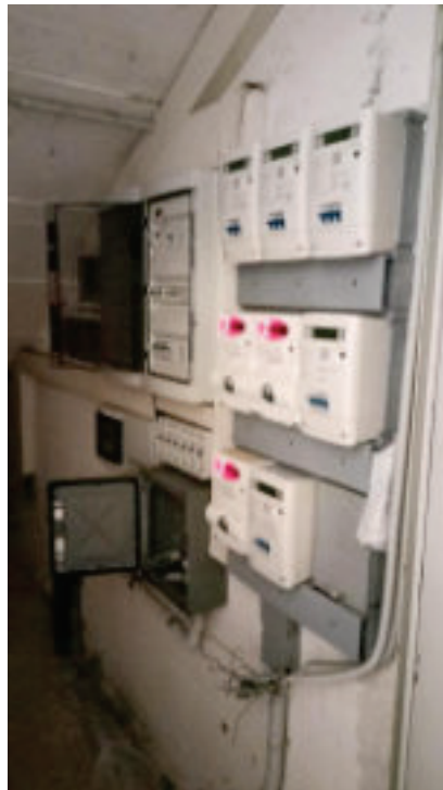
5. Quadro Contatori Energia Elettrica nel locale contatori
